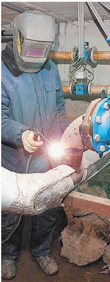
Текут трубы? Вам их заварят. И лучше, чтобы качество работ проверил госконтроль. Фото Эдуарда КУДРЯВИЦКОГО
