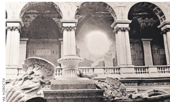
Разрушенное здание Государственного Эрмитажа во время артиллерийского обстрела в дни блокады Ленинграда.
